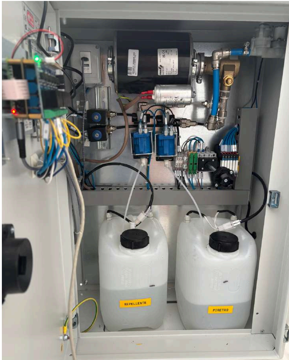
Figura 5 - Zona "Q": circuito elettrico della centralina
